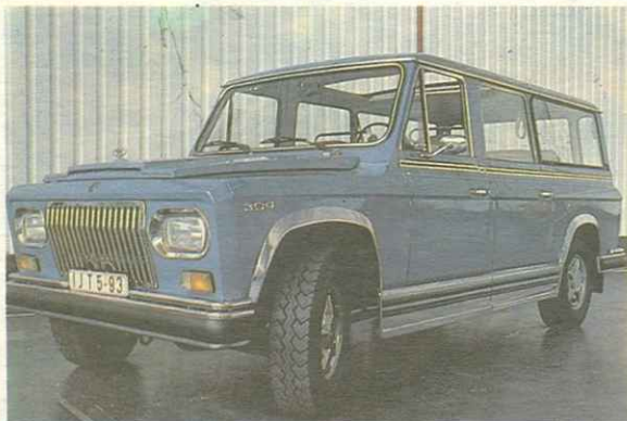
ARO-600. Двигатель — 4 цил., 1397 см 3 , 64 л. с./47 кВт при 5000 об/мин.
